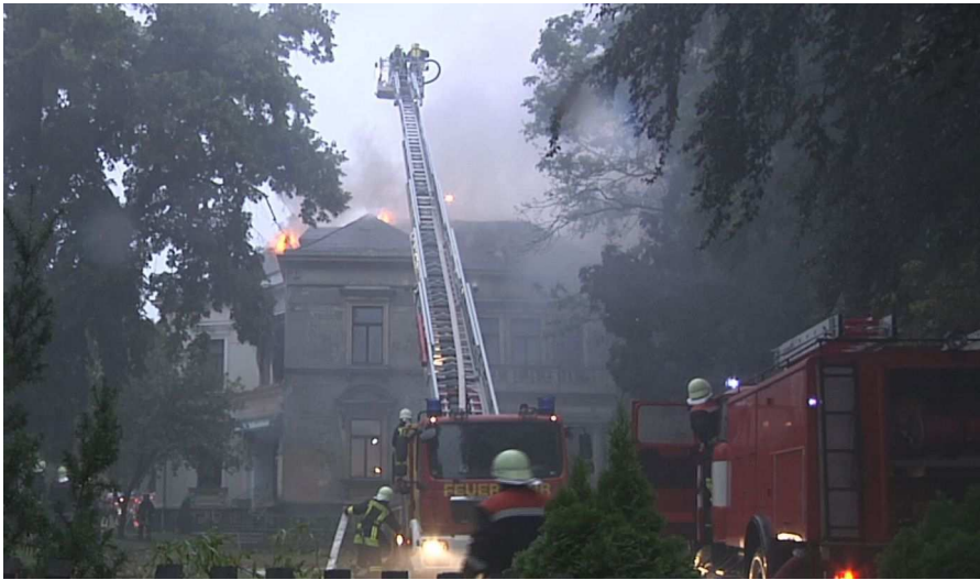
Flammen schlugen aus dem Dach. Die ehemalige Villa des Textilfabrikanten Dr. Ernst Georg Sarfert (G-358) wurde im Sommer 2011 ein Opfer der Flammen. Seit 1974 nutzt die Volkssolidarität das Objekt. Zu DDR-Zeiten unterhielt die Staatssicherheit Arrestzellen im Keller.
