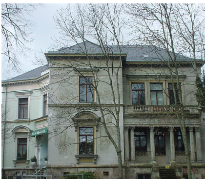
Januar 2005. Immer wieder sind umfangreiche Sanierungen und Modernisierungen erforderlich, die der Stadt sehr viel Geld kosteten.
