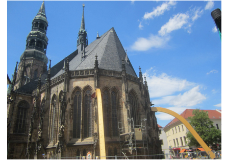
Marienkirche Zwickau. Sanierungsarbeiten an den Fundamenten.
