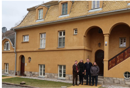
Gelungene Sanierung 2017. Ein Mehrfamilienwohnhaus mit 5 Wohnungen unweit von Leipzig.
