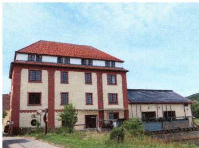
Mühle 2019. Mit Wasserkraft wird Strom erzeugt. Weitere Hotelzimmer entstanden im oberen Bereich.
